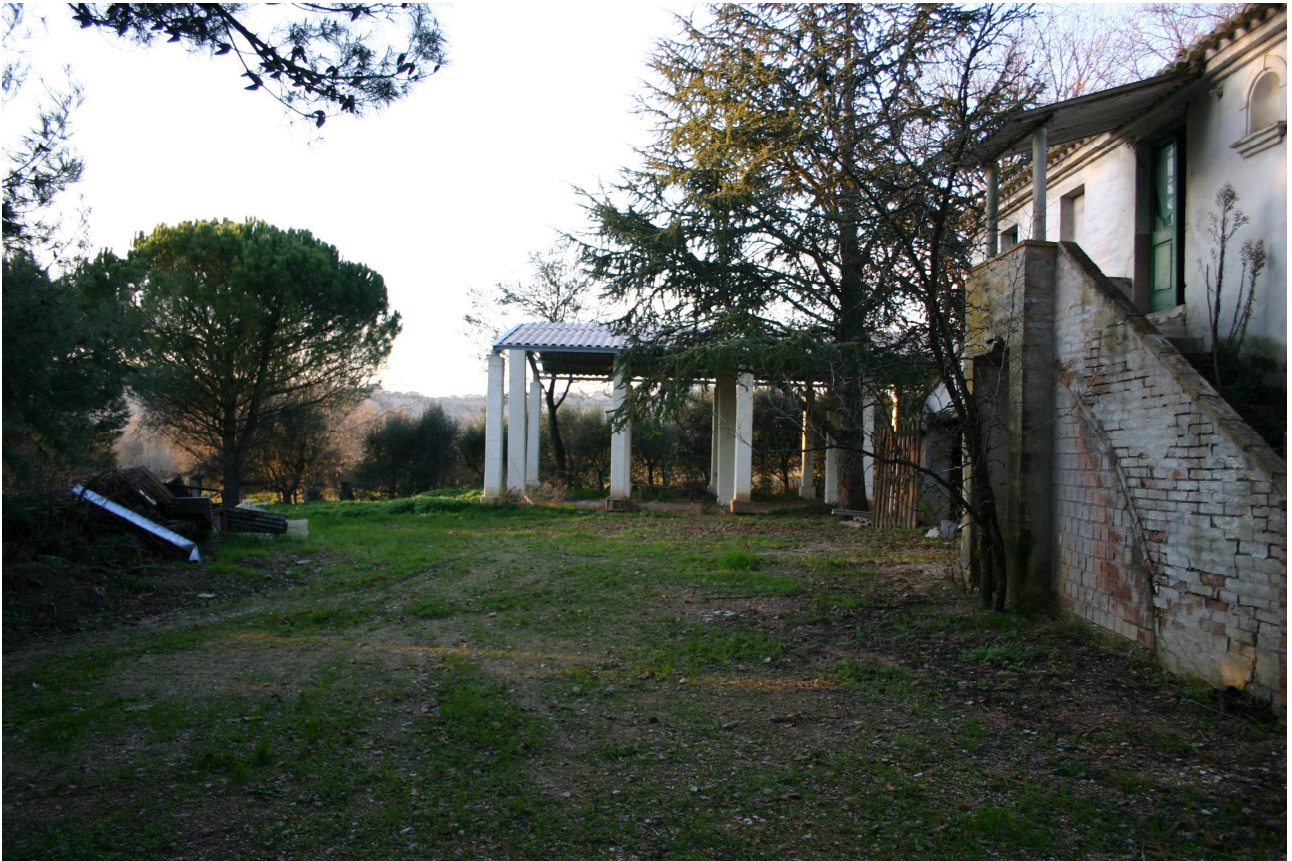
Immagine 2 – Foto dello stato iniziale del complesso edilizio prima dell’inizio dell’intervento.
