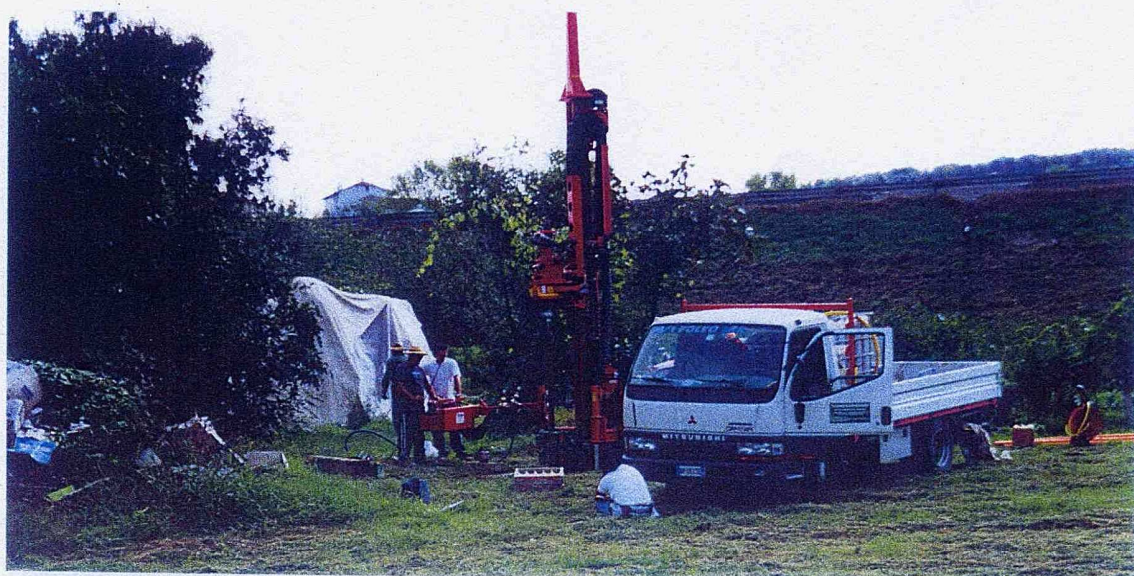
FOTO 3: Ubicazione sondaggio a carotaggio continuo attrezzato a piezometro
