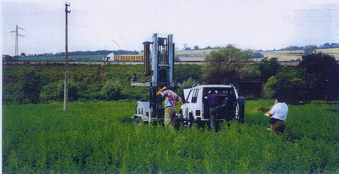
FOTO 1: Ubicazione prova penetrometrica statica P.1
