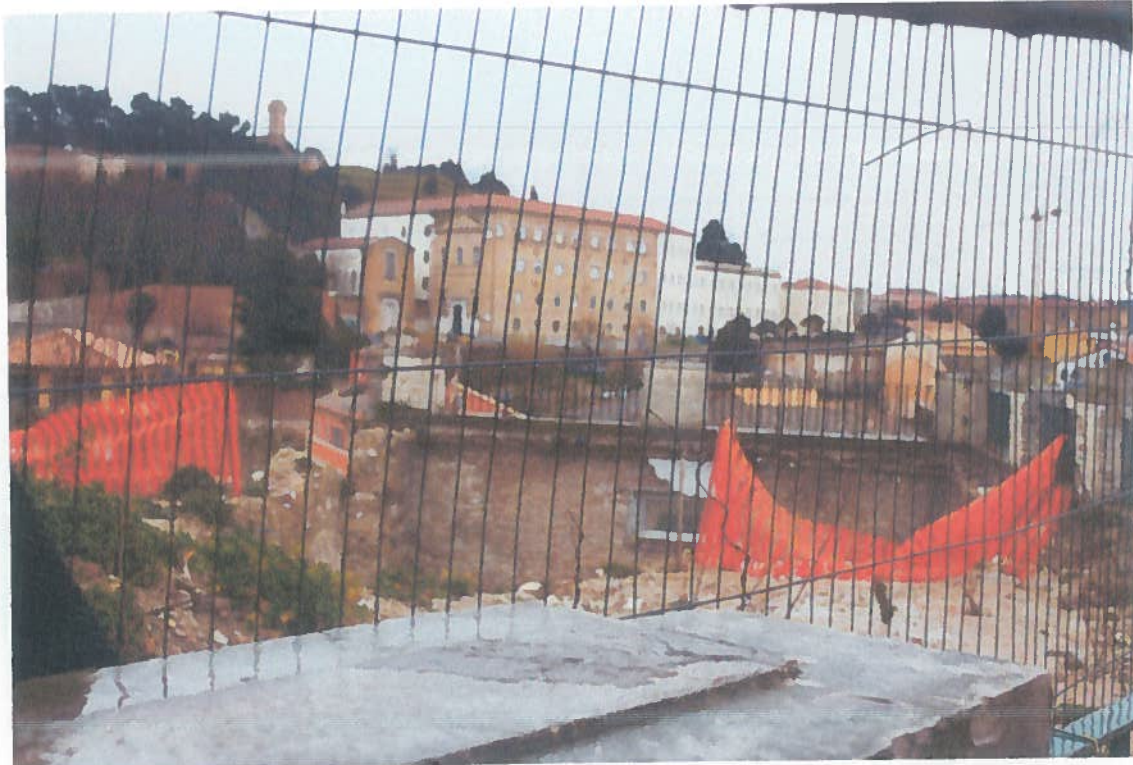
Area destinata alla nuova APC 43 (sopralluogo fotografico).
