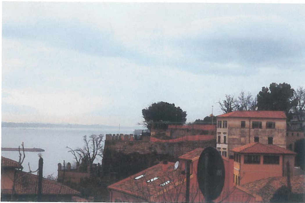
Area destinata alla nuova APC 43 (sopralluogo fotografico).
