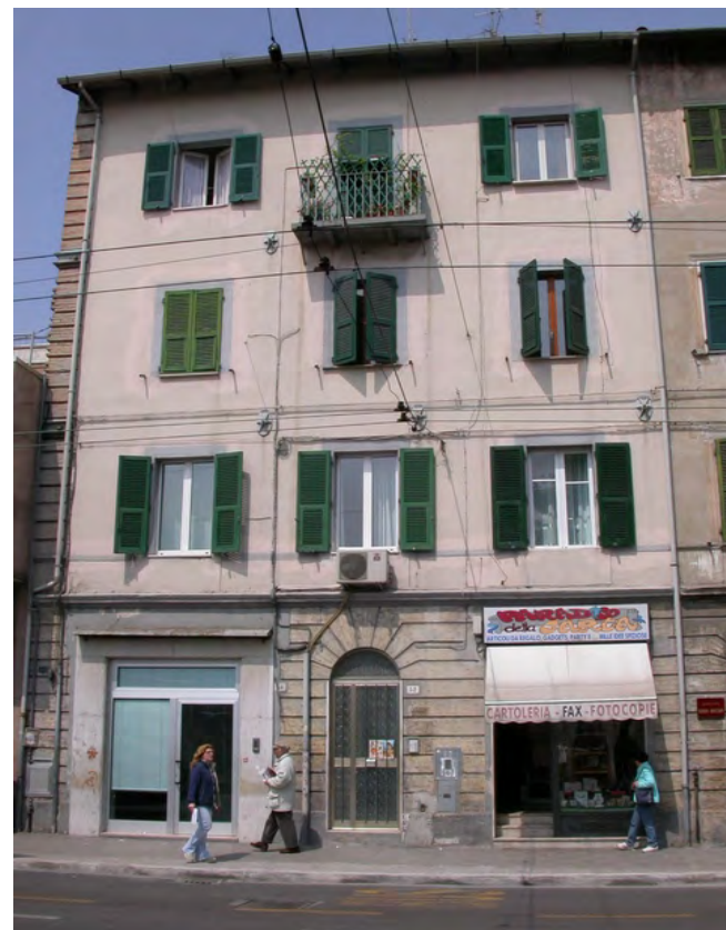
1 vista del fronte
