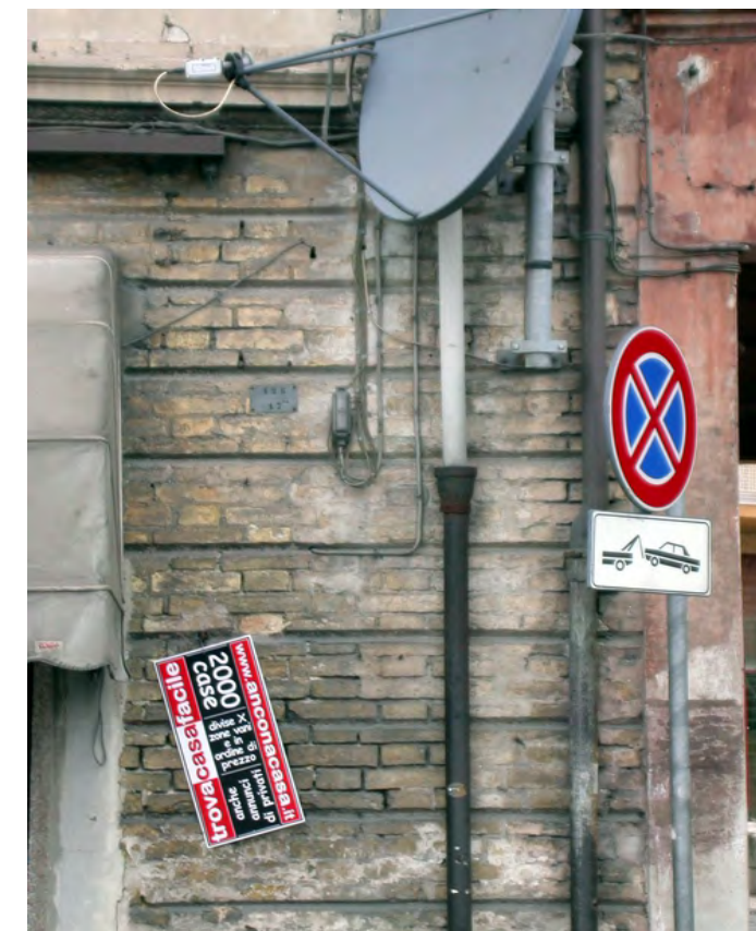
2_ basamento: bugnato in laterizio con velatura
