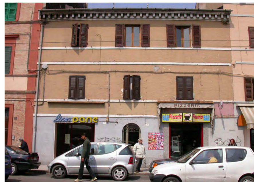
1 vista del fronte
