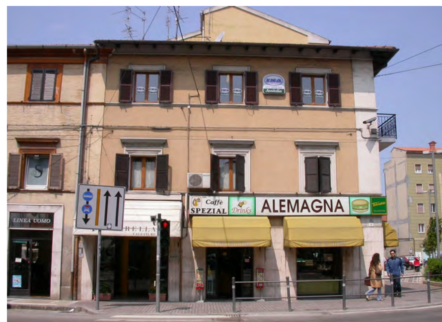
1_ vista del fronte su via C. Colombo
