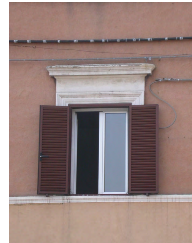
3_ mostra con modanature e trabeazione
