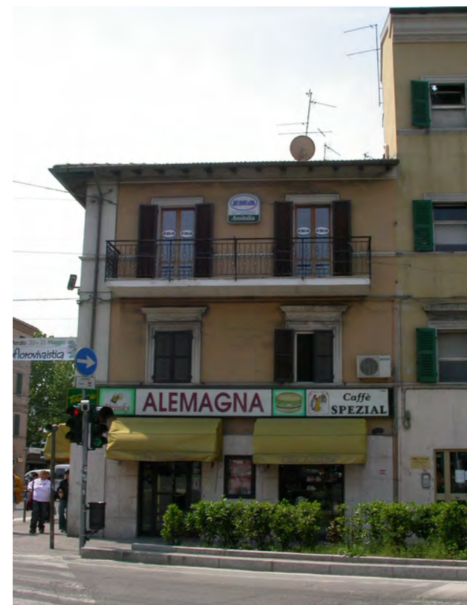
2_ vista del fronte su piazza Ugo Bassi
