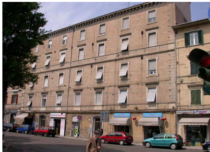
1_ vista generale del fronte
