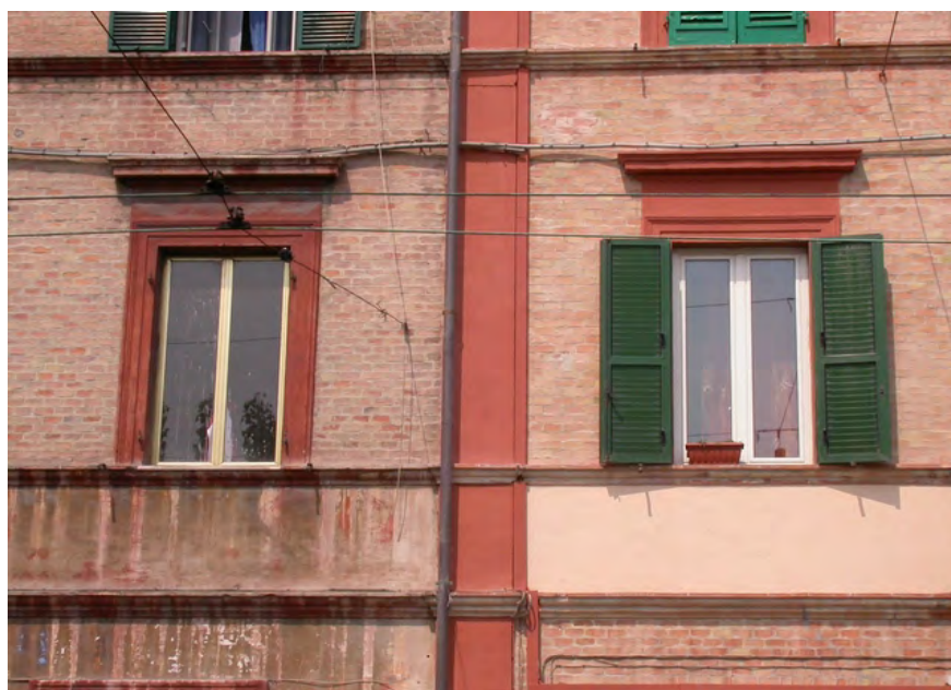
1 mostre, paraste cantonali, fasce marcapiano
