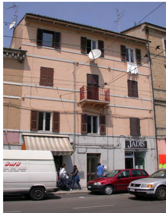
1 vista del fronte
