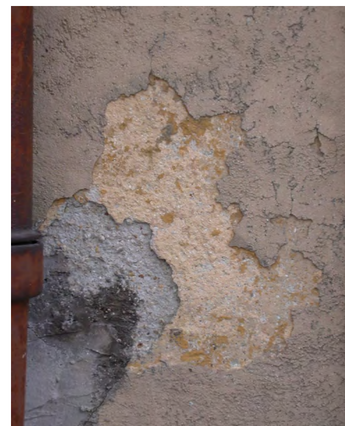
3_ basamento. Stratigrafia di intonaci e pitture
