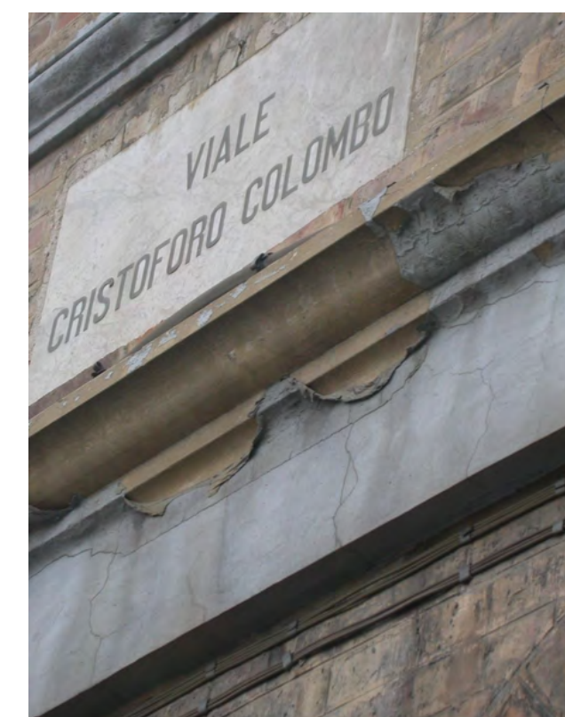
4_ fascia marcapiano alta e modanata
