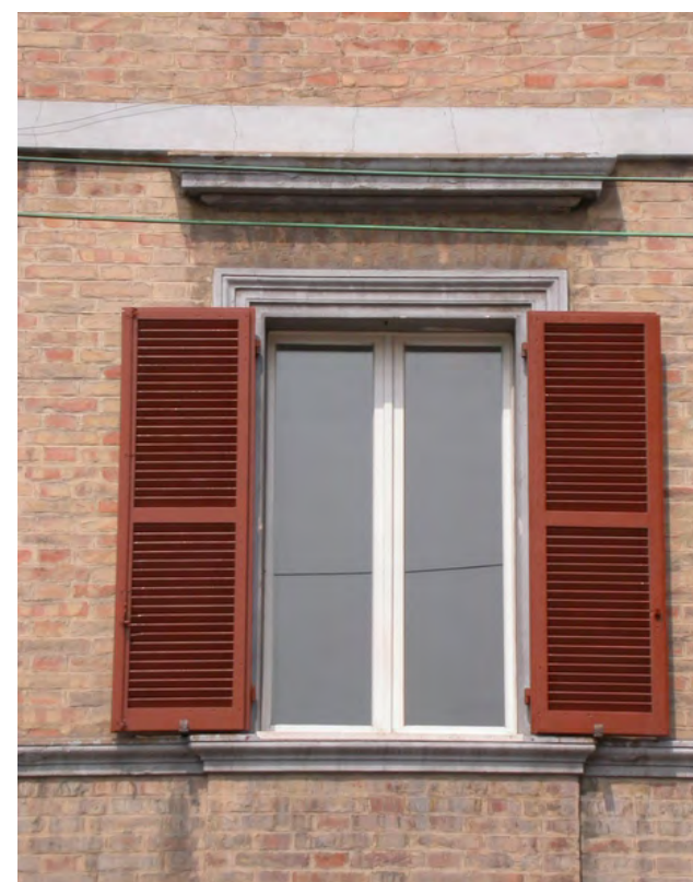
3_ finestra: riquadro modanato con trabeazione staccata
