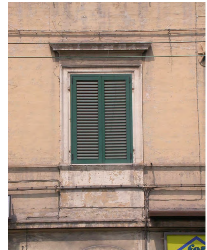
2_ finestra: mostre modanate con trabeazione e specchiature
