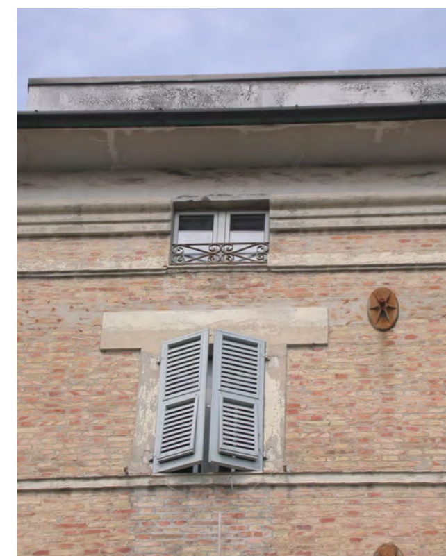
4_ mostra di finestre e cornice
