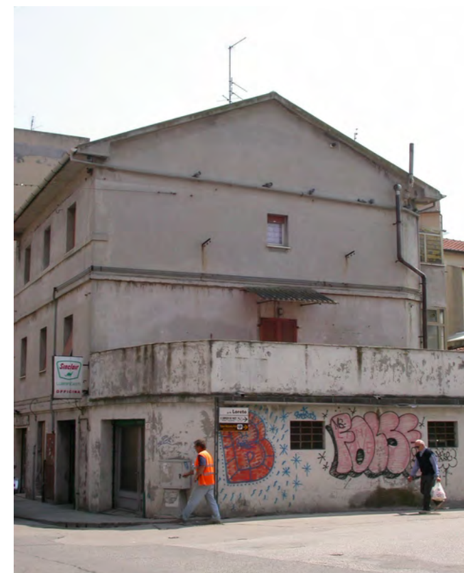
2_ vista del fronte su piazzale Loreto
