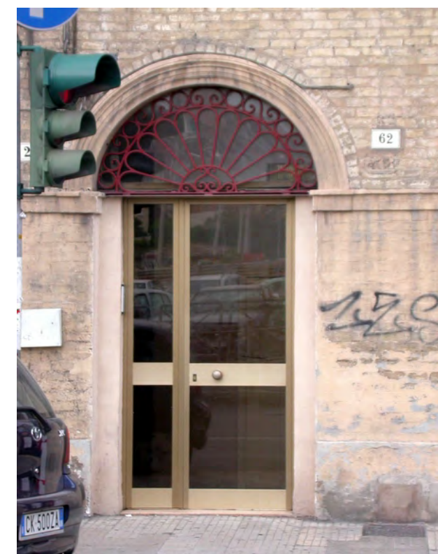
2_ porta ingresso e basamento con tracce di tonachino
