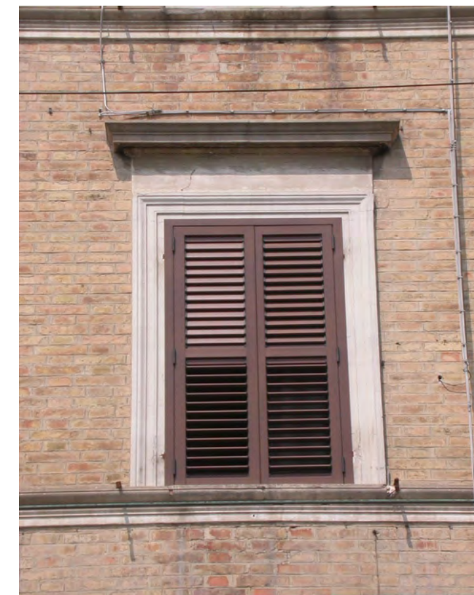
2_ finestra: mostra modanata con trabeazione
