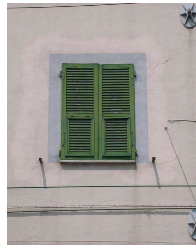
3_finestra: riquadro con pittura
