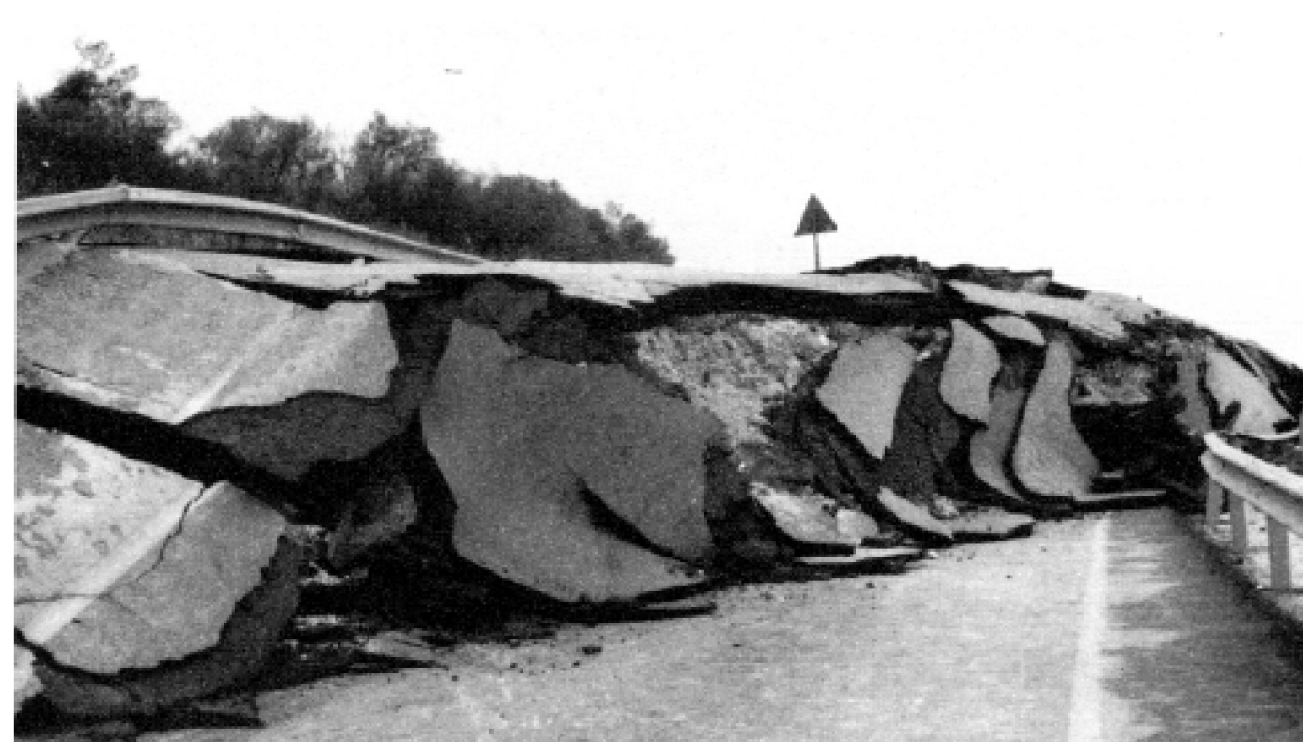
La Flaminia e i binari della ferrovia Tra Palombella e Borghetto travolti dalla frana
