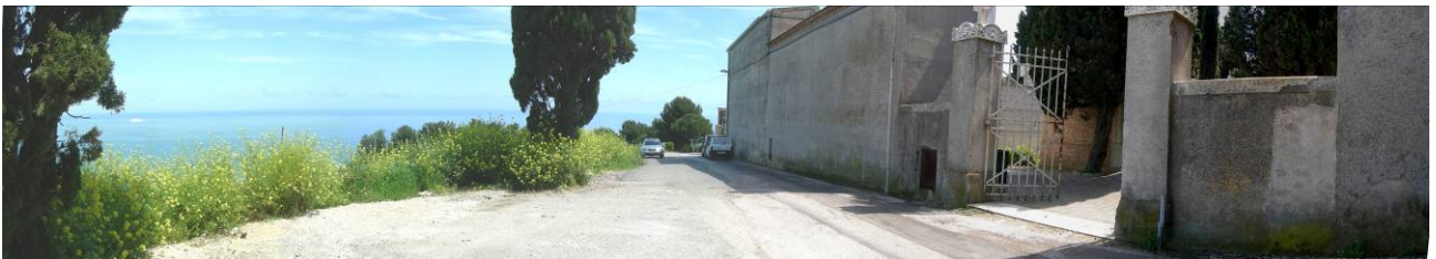
Ingresso principale al cimitero: punto di ripresa dalla strada di accesso
