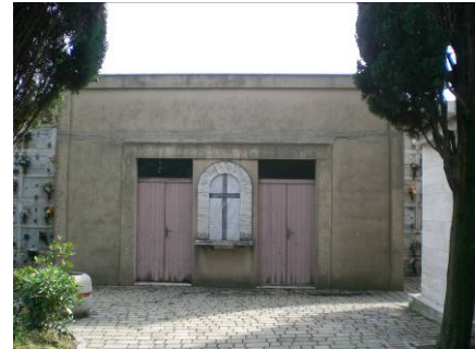
Ex camera mortuaria. Tale locale accessorio potrà essere adibito a ossario/cinerario o servizi igienici
