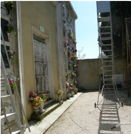
Veduta della costruzione destinata a chiesa per officiare funzioni ora dimessa, che potrà essere adibita a ossario/cinerario o servizi igienici
