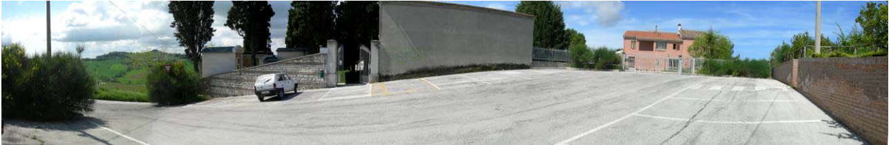
Veduta delle mura di cinta del cimitero e dal parcheggio
