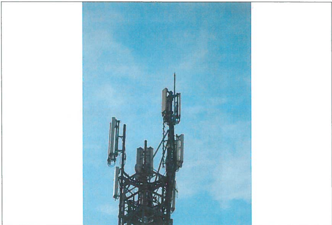
Vista della SRB esistente (sistema radiante) - punto di vista 3
