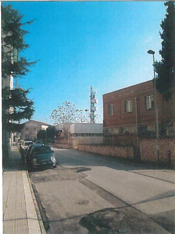
Vista d'insieme della SRB esistente - punto di vista 1
