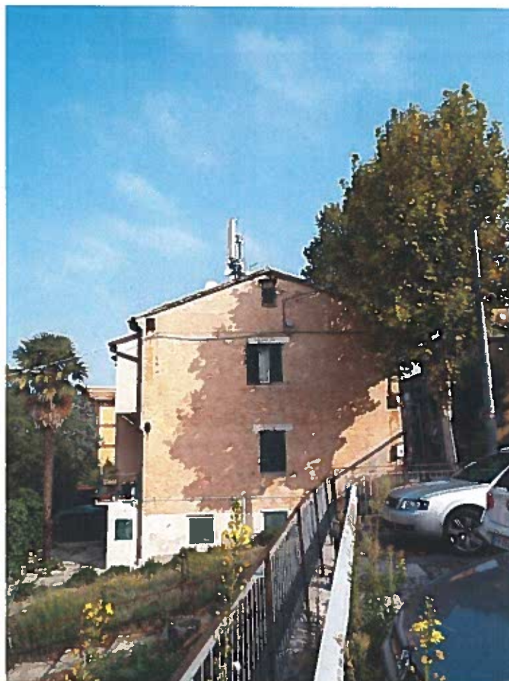
Foto 1 - Area su cui è installata la S.R.B.
