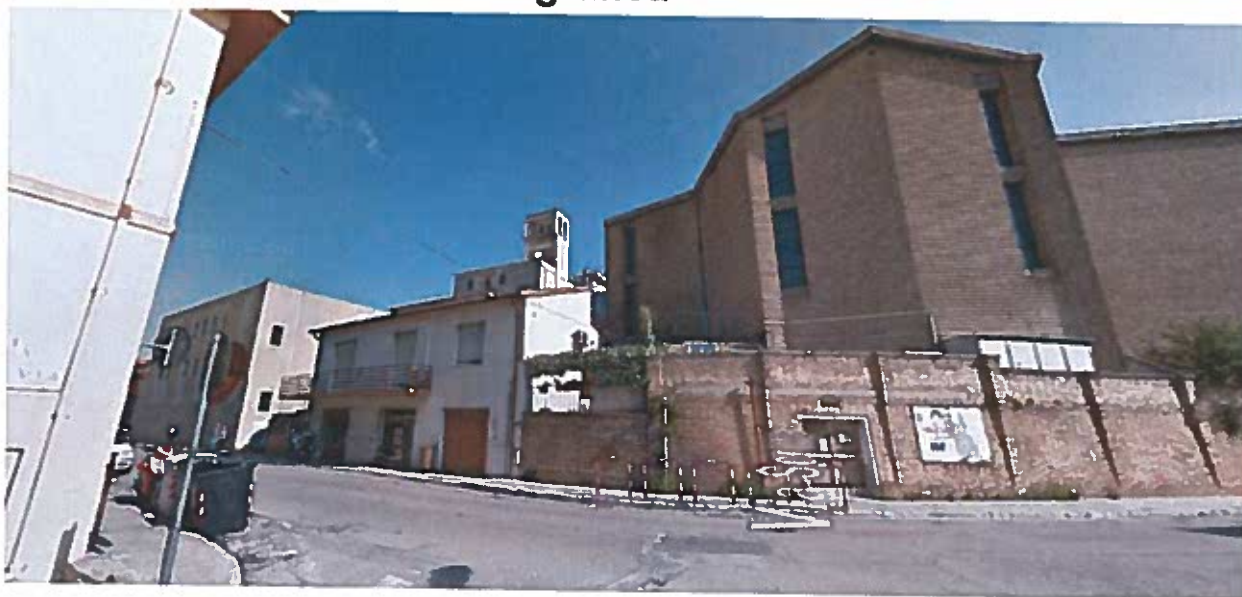
Foto 1 – Area su cui è installata la SRB.
