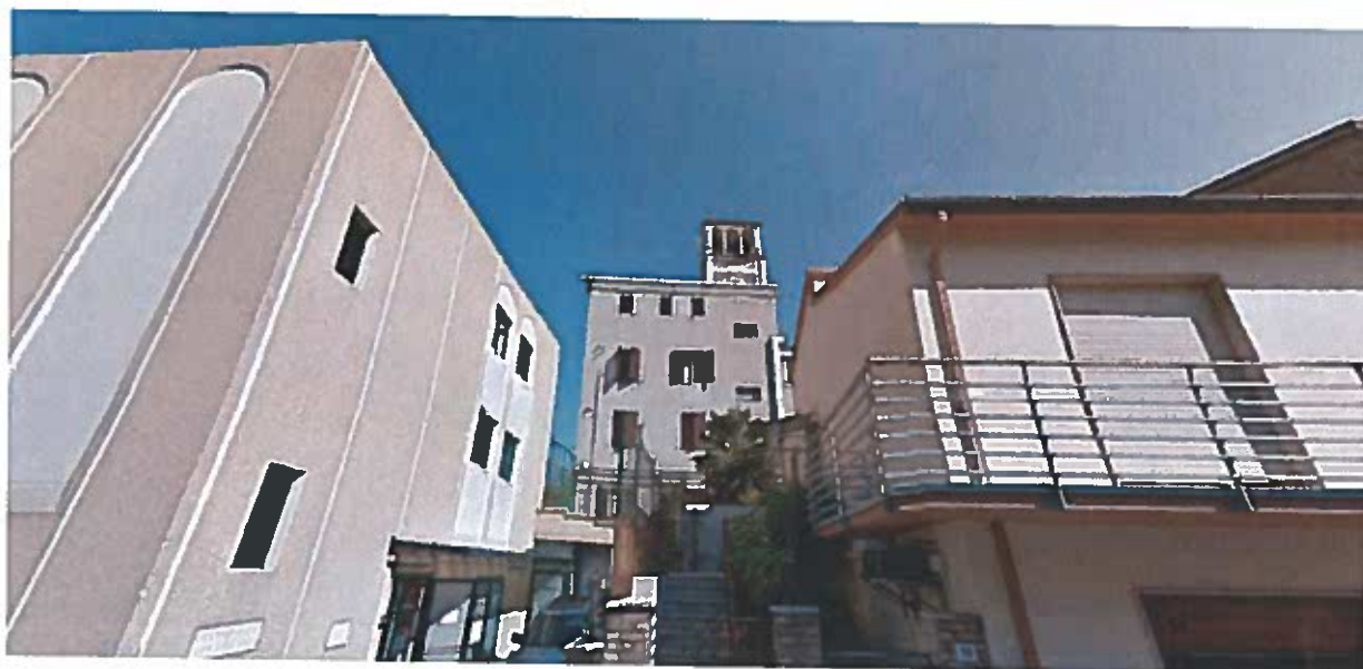
Foto 2 – Area su cui è installata la SRB.
