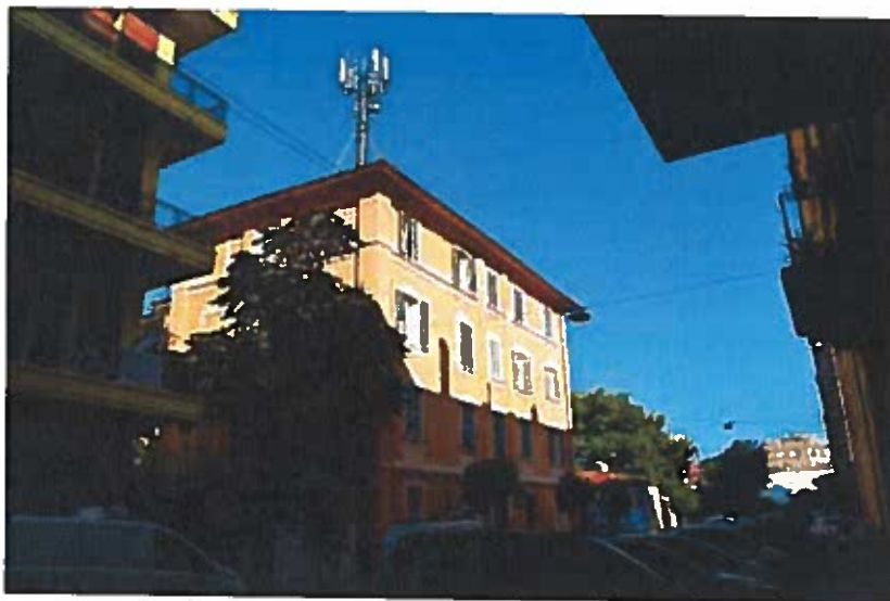
Foto 1 – Area su cui è installata la SRB.
