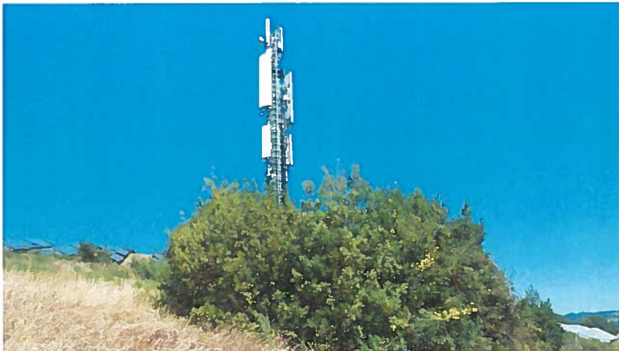
Foto 1 - Area su cui è installata la S.R.B.
