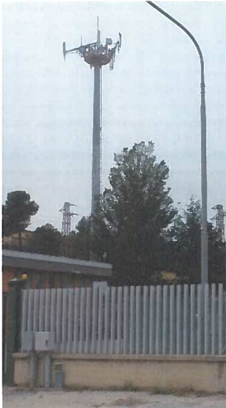
Foto 1 - Area su cui è installata la S.R.B.
