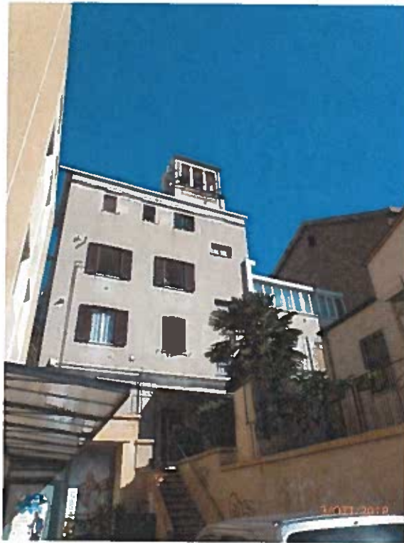
Foto 1 - Area su cui è installata la S.R.B.
