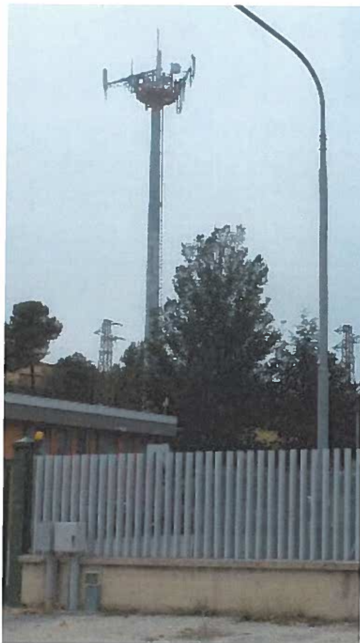
Foto 1 - Area su cui è installata la S.R.B.
