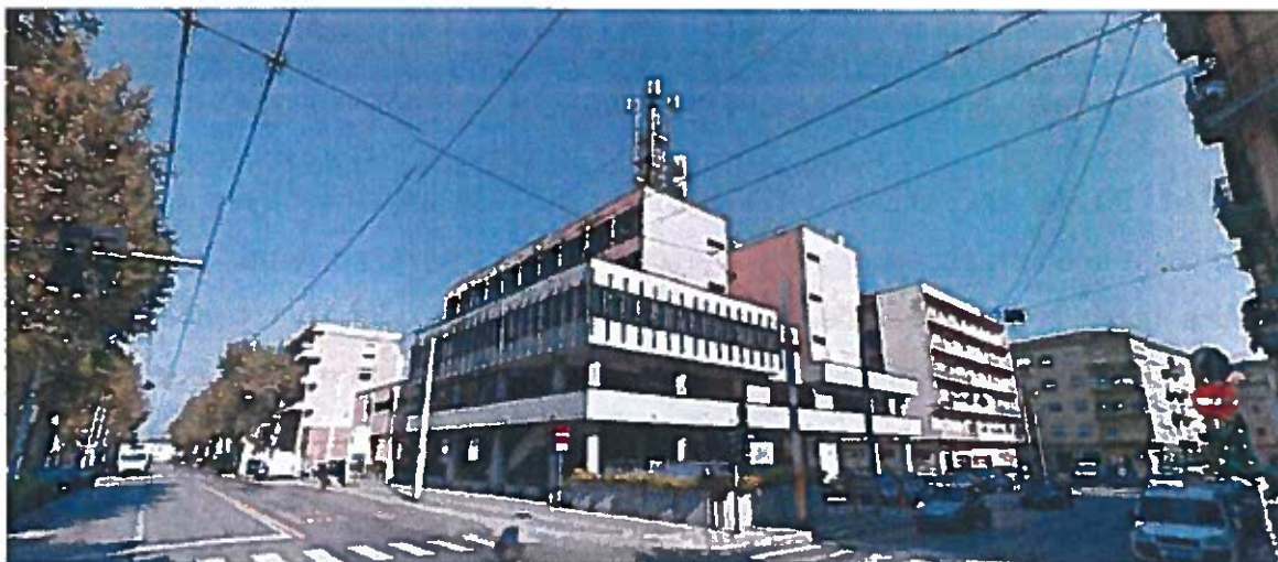
Foto 1 – Area su cui è installata la SRB.
