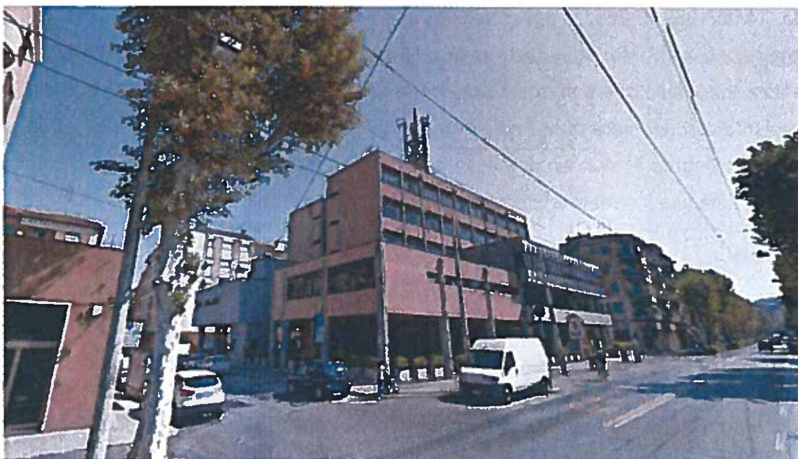
Foto 2 – Area su cui è installata la SRB.
