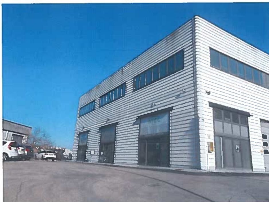
FOTO B _STATO ATTUALE
