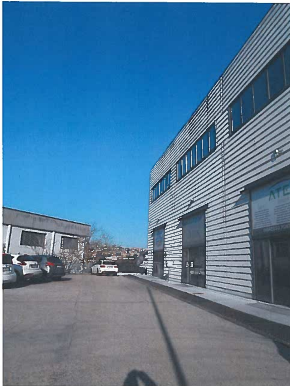
FOTO A_STATO ATTUALE
