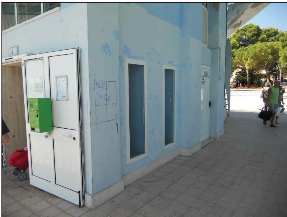
Foto n.7- Blocco ascensori, lato nord q:+38,53m
