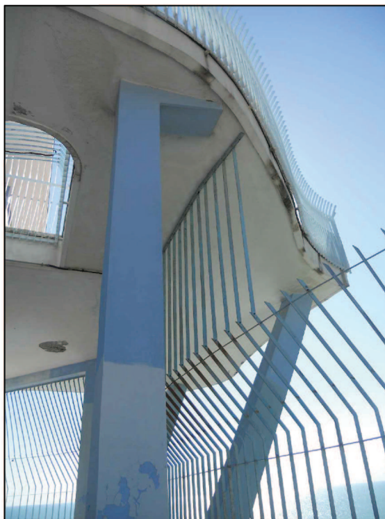
Foto n.13- Attacco con solaio
