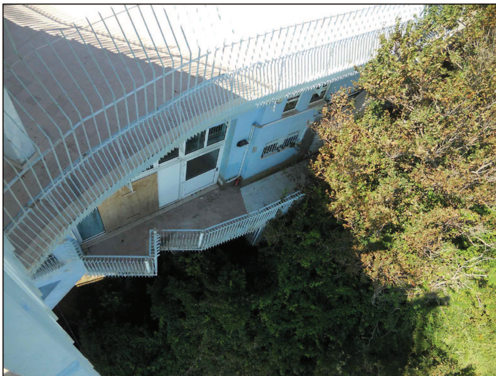
Foto n.55- Vista sull'ingresso del locale interrato, lato nord
