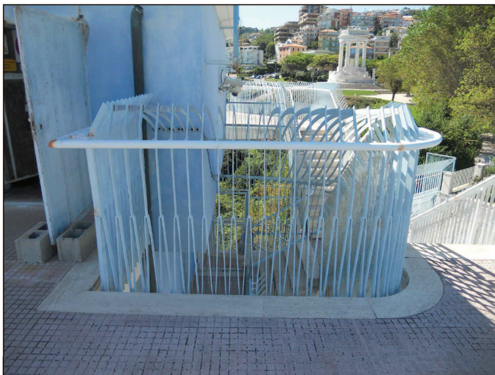
Foto n.36- Dettagli parapetto terrazza q:+43,93m
