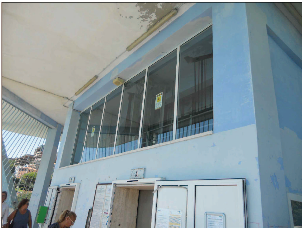
Foto n.8- Blocco ascensori, lato est q:+38,53m
