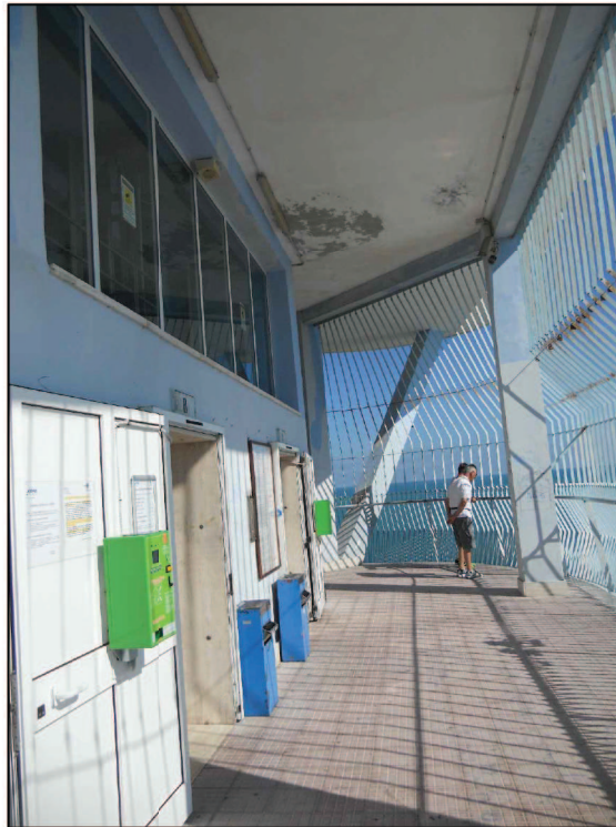
Foto n.9- Blocco ascensori, lato nord q:+38,53m
