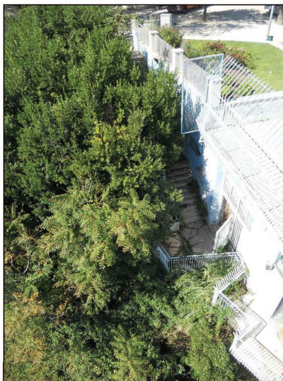
Foto n.56- Vista sull'ingresso del locale interrato, lato sud
