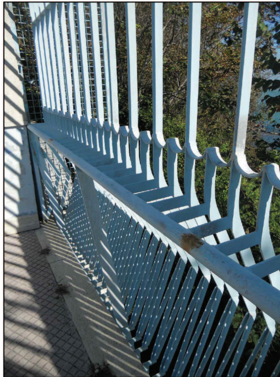
Foto n.15- Dettagli parapetto q:+38,53m
