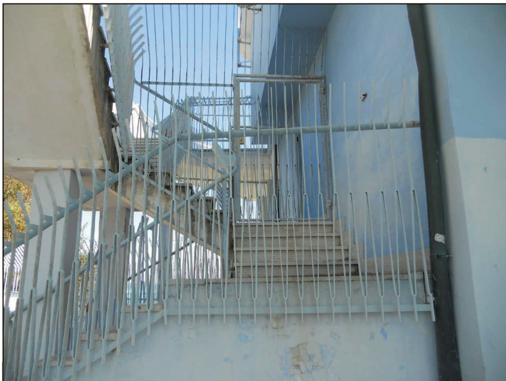
Foto n.20 Scala di accesso alla terrazza superiore a q:+38,53m
