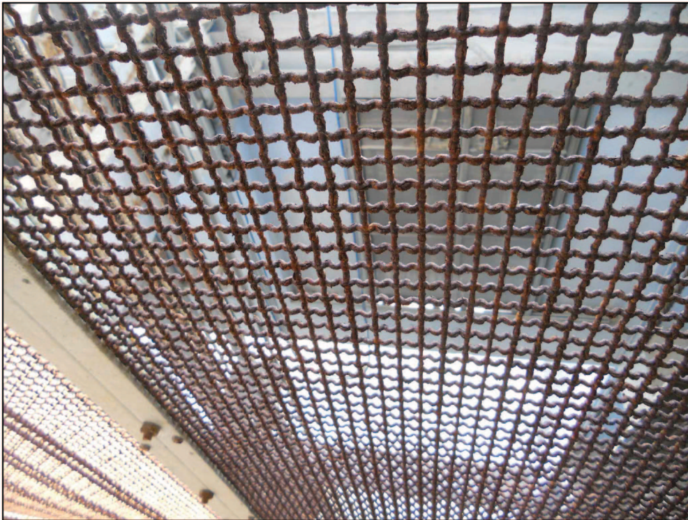
Foto n.45- Dettaglio grata chiusura ascensore q:+20,88m
