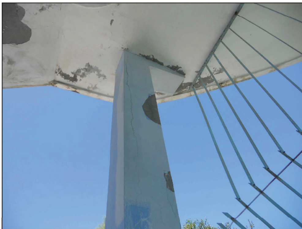
Foto n.14- Attacco con solaio
