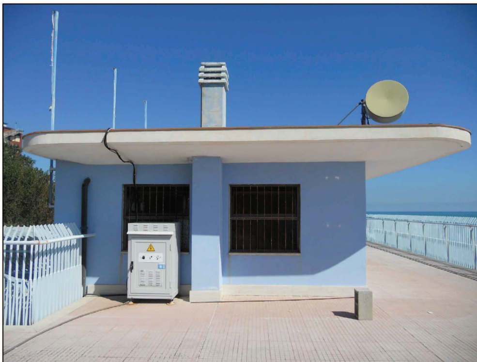
Foto n.29- Locale macchine visto dalla terrazza, lato sud q:+43,93m
