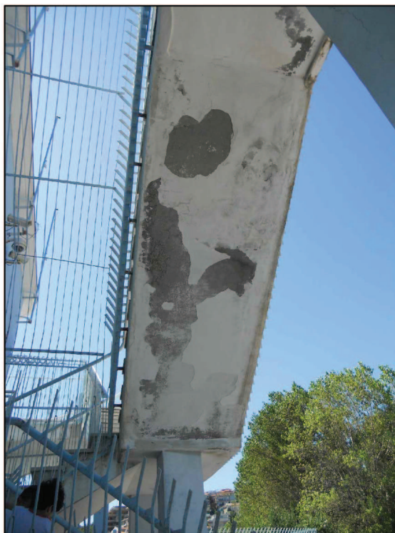
Foto n.25- Scala di accesso alla terrazza superiore a q:+43,93m
