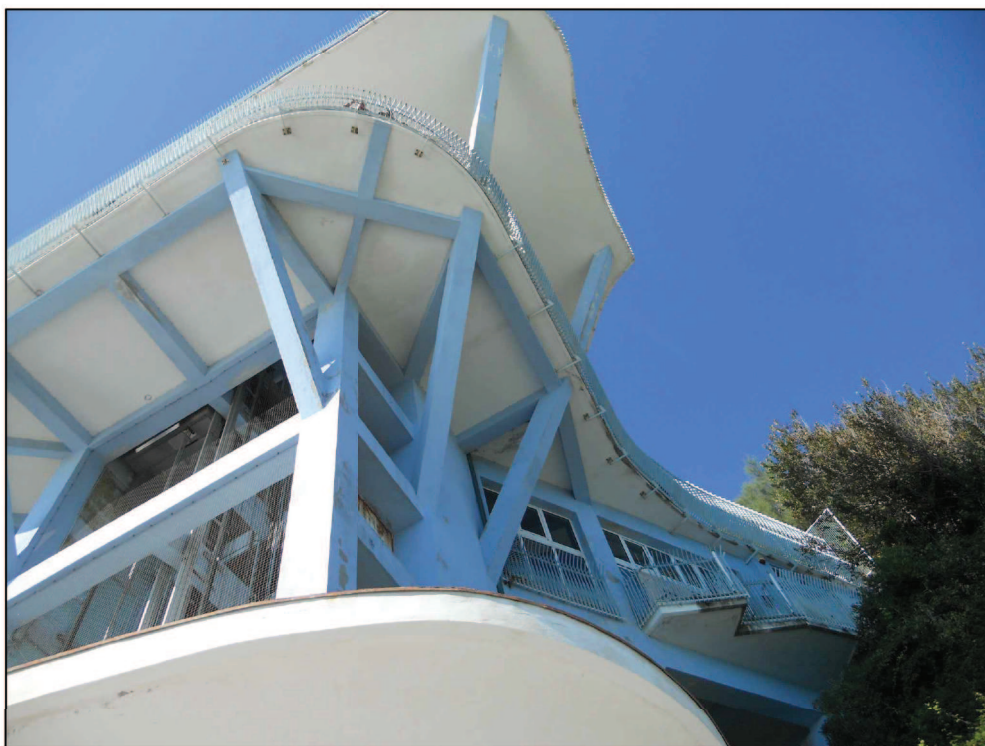
Foto n.54- Viste d'insieme, lato nord-est
