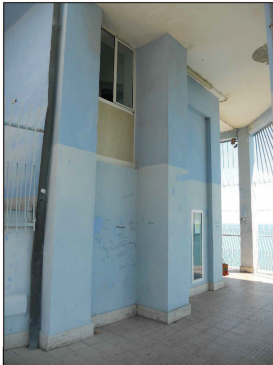
Foto n.10- Blocco ascensori, lato sud q:+38,53m
