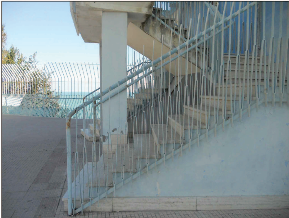
Foto n.19- Scala di accesso alla terrazza superiore a q:+38,53m
