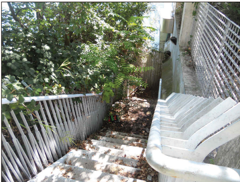
Foto n.57- Scale di accesso al locale interrato, lato nord
