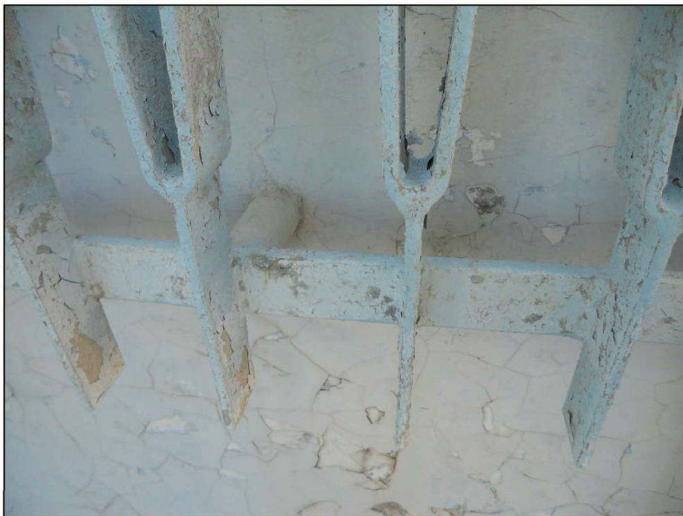
Foto n.22- Scala di accesso alla terrazza superiore a q:+38,53m, dettagli parapetto
