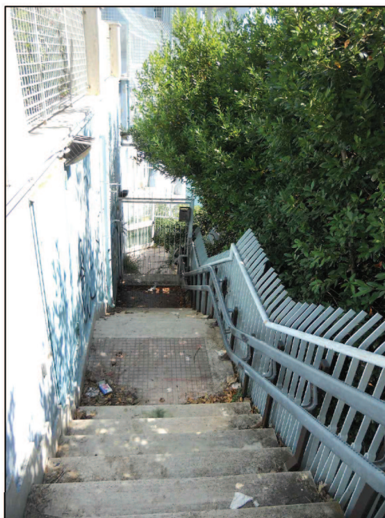
Foto n.58- Scale di accesso al locale interrato, lato sud
