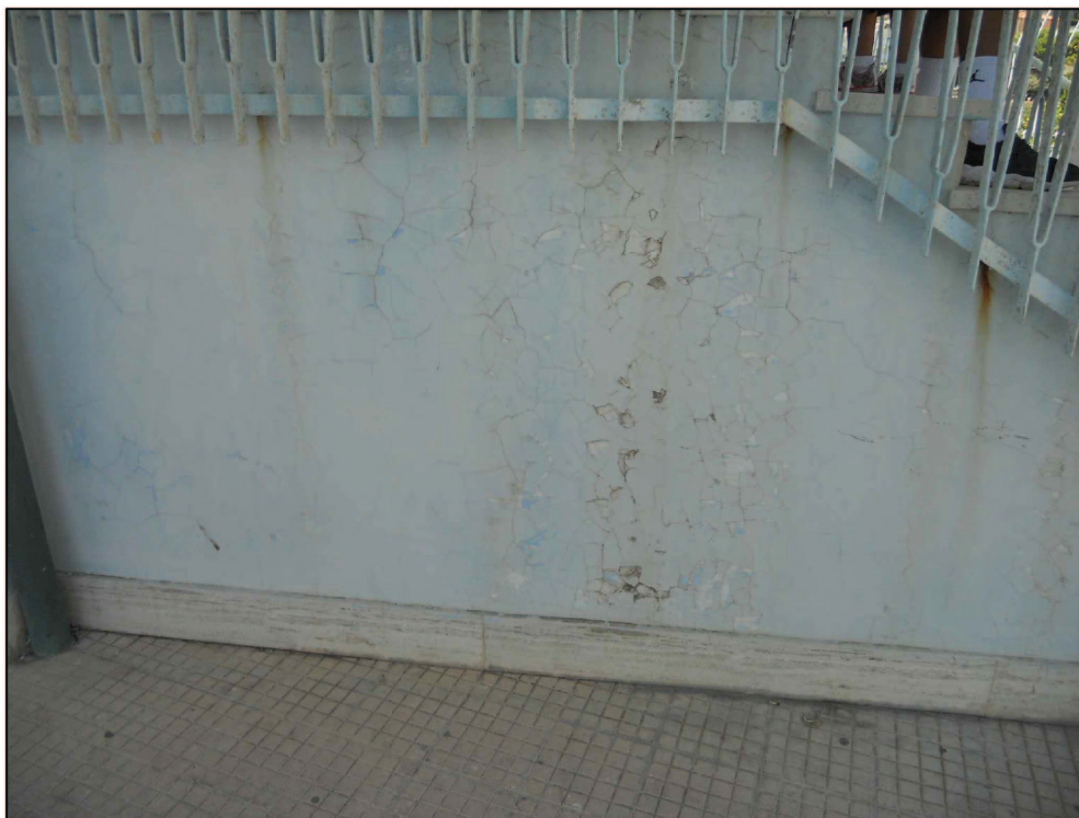
Foto n.21- Scala di accesso alla terrazza superiore a q:+38,53m
