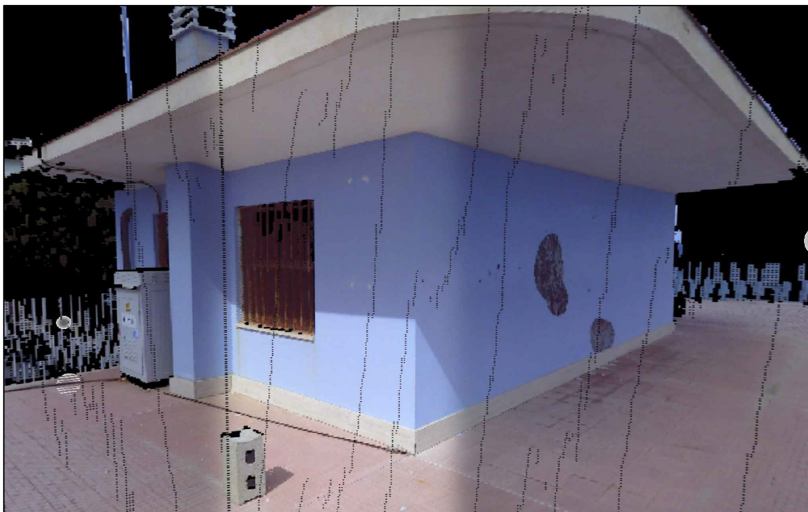
Immagine n.1- Locale macchine visto dalla terrazza q: +43,93m
