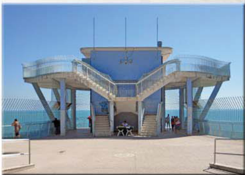
VISTA 4A (Ovest) - Stato di fatto
