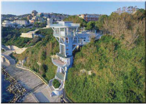
VISTA 3A (Nord-Est) - Stato di fatto
