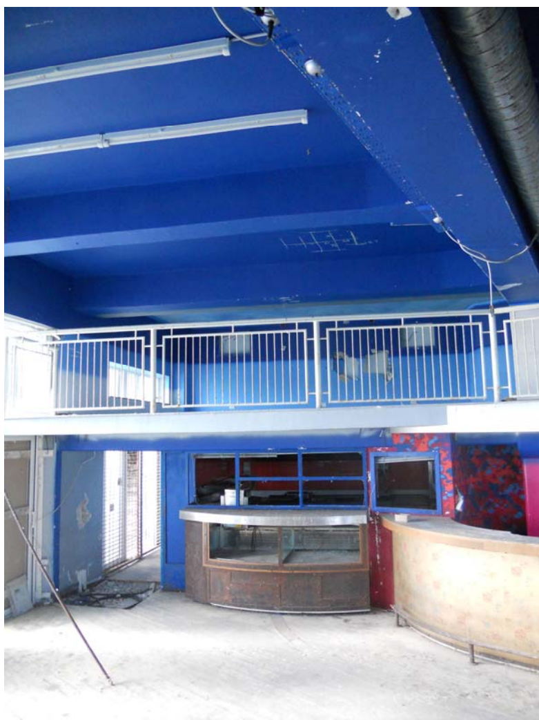
stato attuale locale
