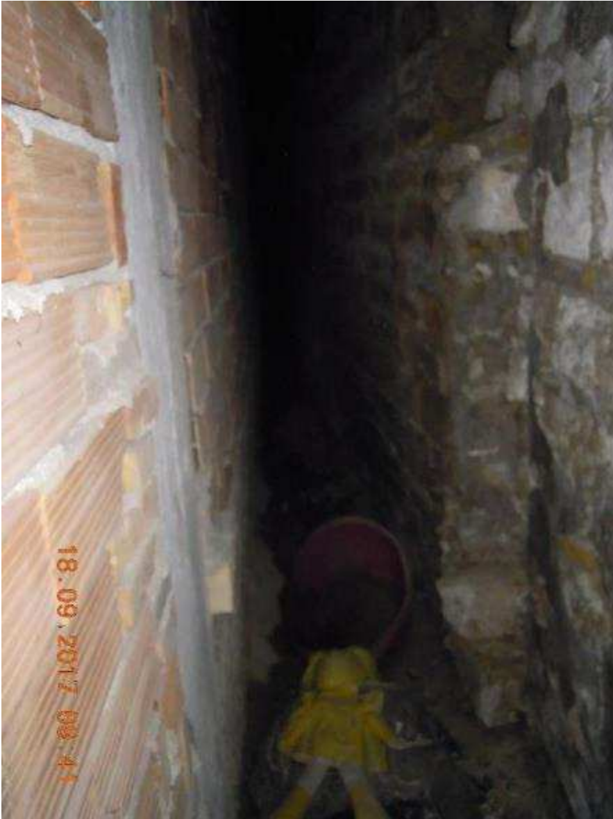
Foto n.18: interno muro controterra a gravità in pietra (piano terra)
