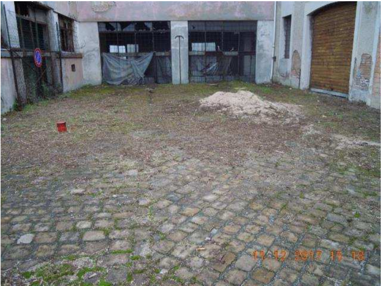
Foto n.6: esterno piazzale antistante in cubetti in pietra da smontare e accatastare.
