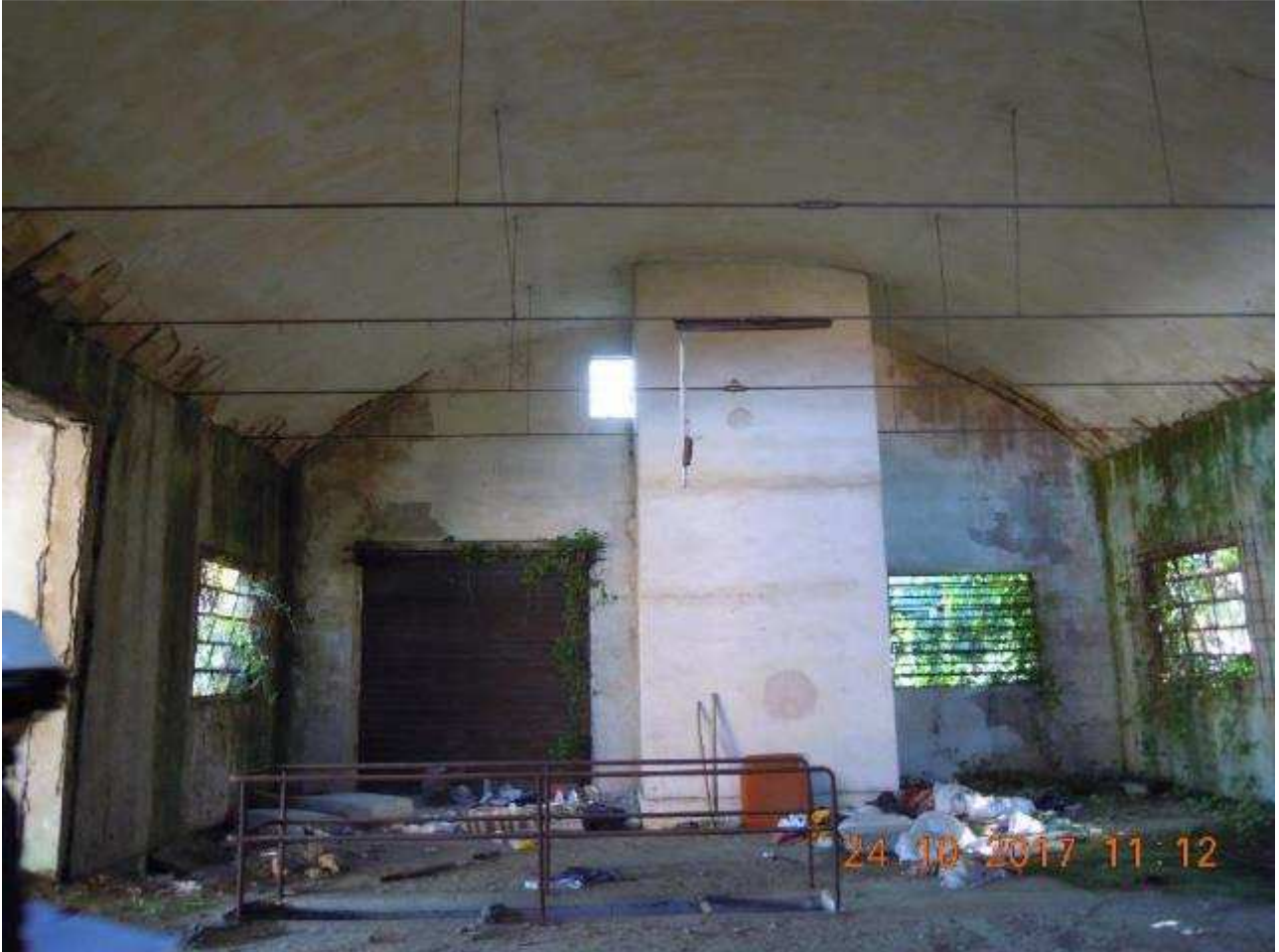
Foto n. 12: Interno edificio E2
