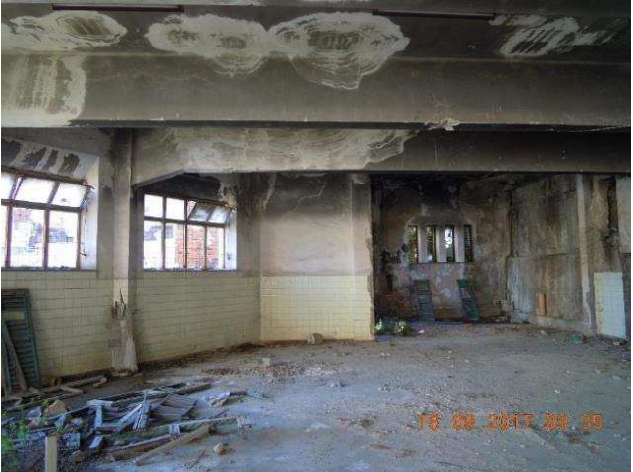
Foto n. 8: vista interna edificio E1
