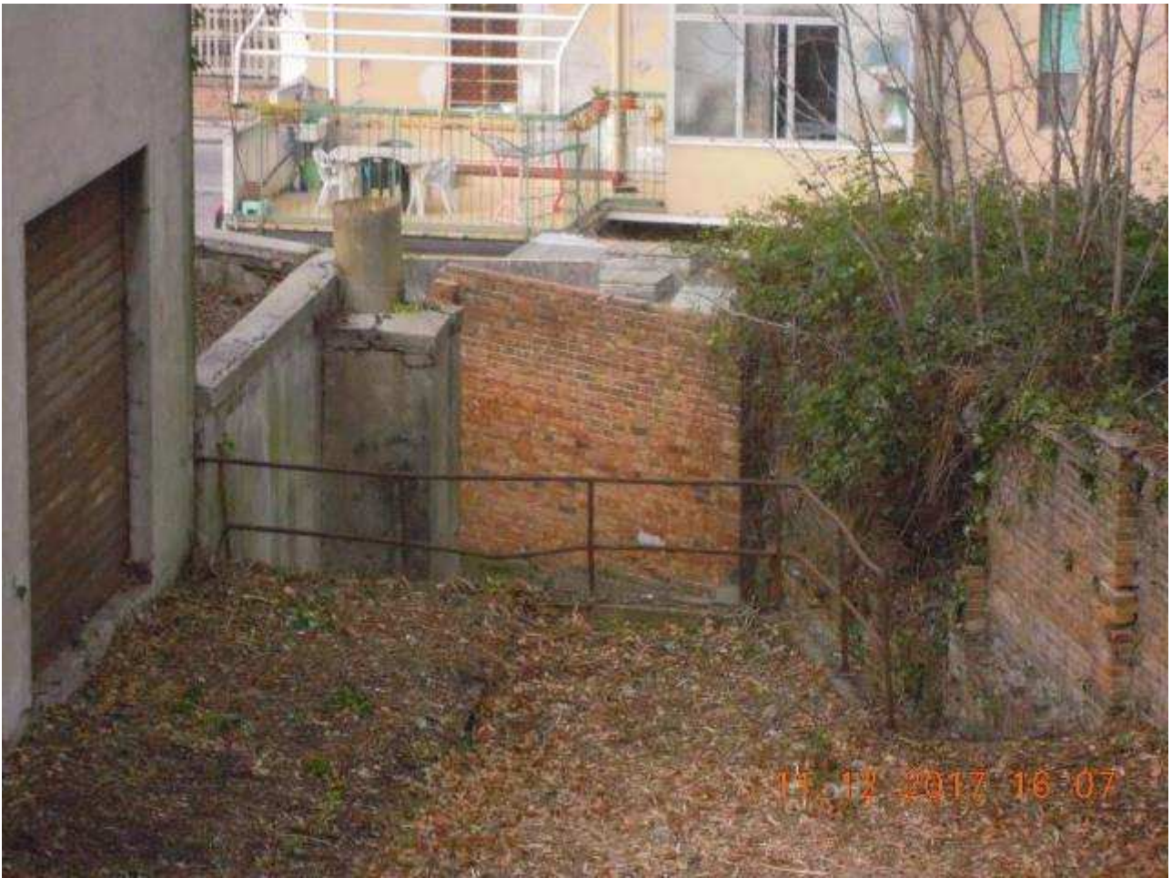
Foto n. 14: esterno portone di accesso edificio E2
