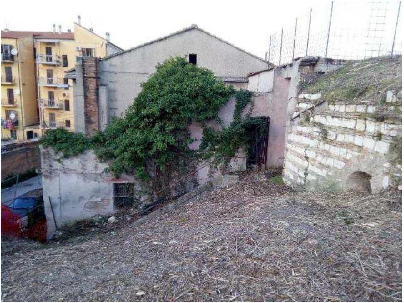
Foto n.21: vista esterna del contrafforte terminale del muro controterra in pietra (piano primo).
