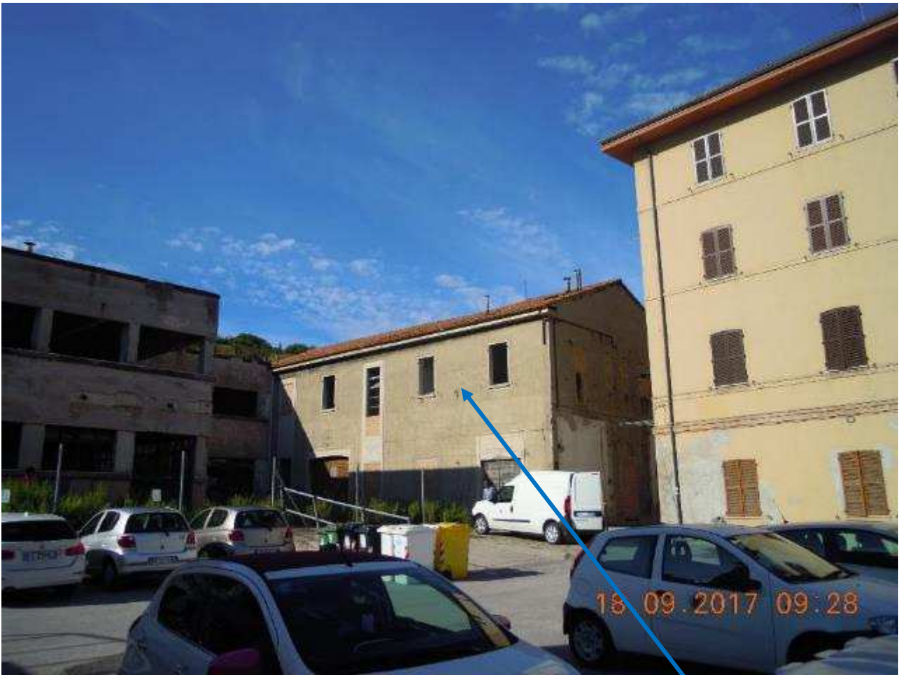
Foto n. 2: vista del complesso edilizio. Edificio E2 (blu)
