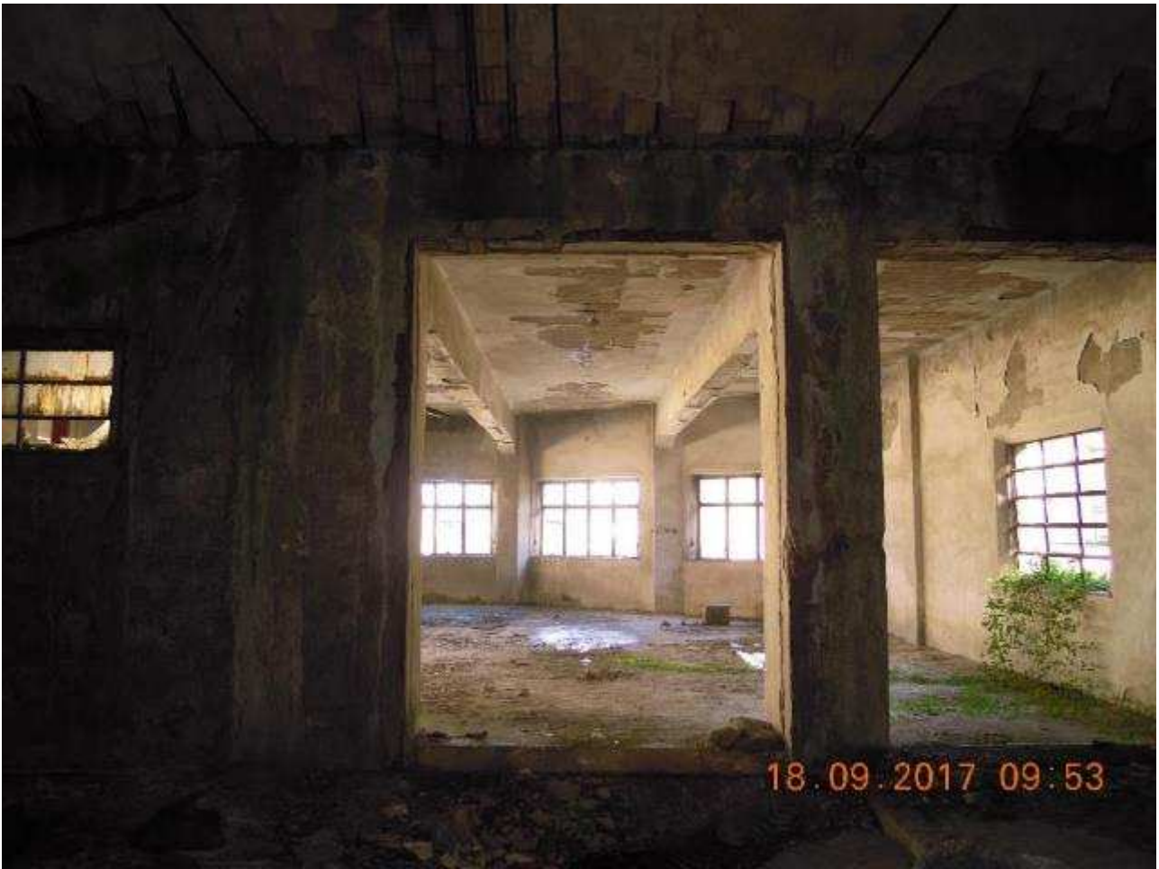
Foto n. 11: Piano primo. Vista edificio E1 dal piazzale di carico edificio E2
