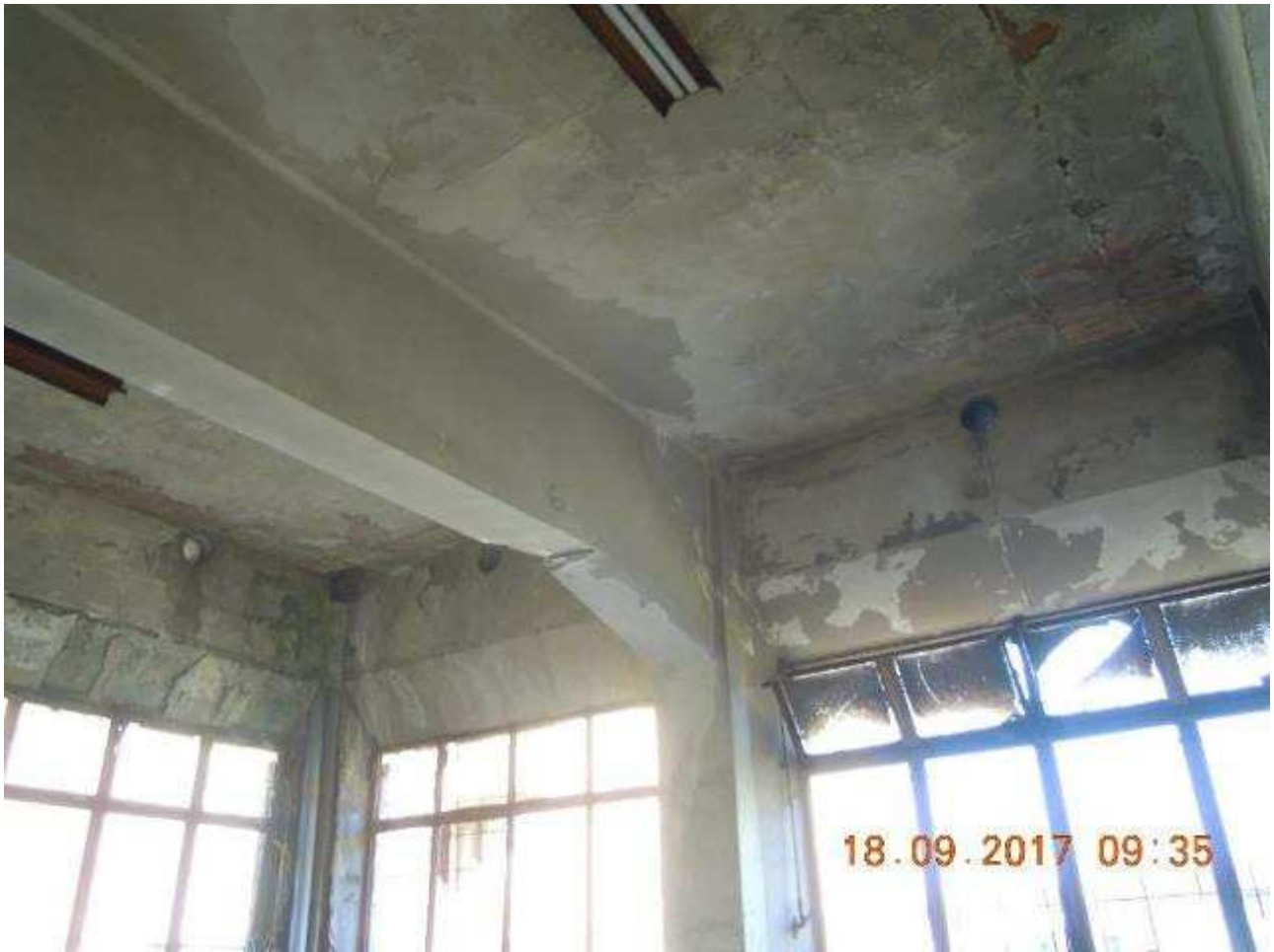
Foto n. 9: dettaglio nodo strutturale telaio portante edificio E1
