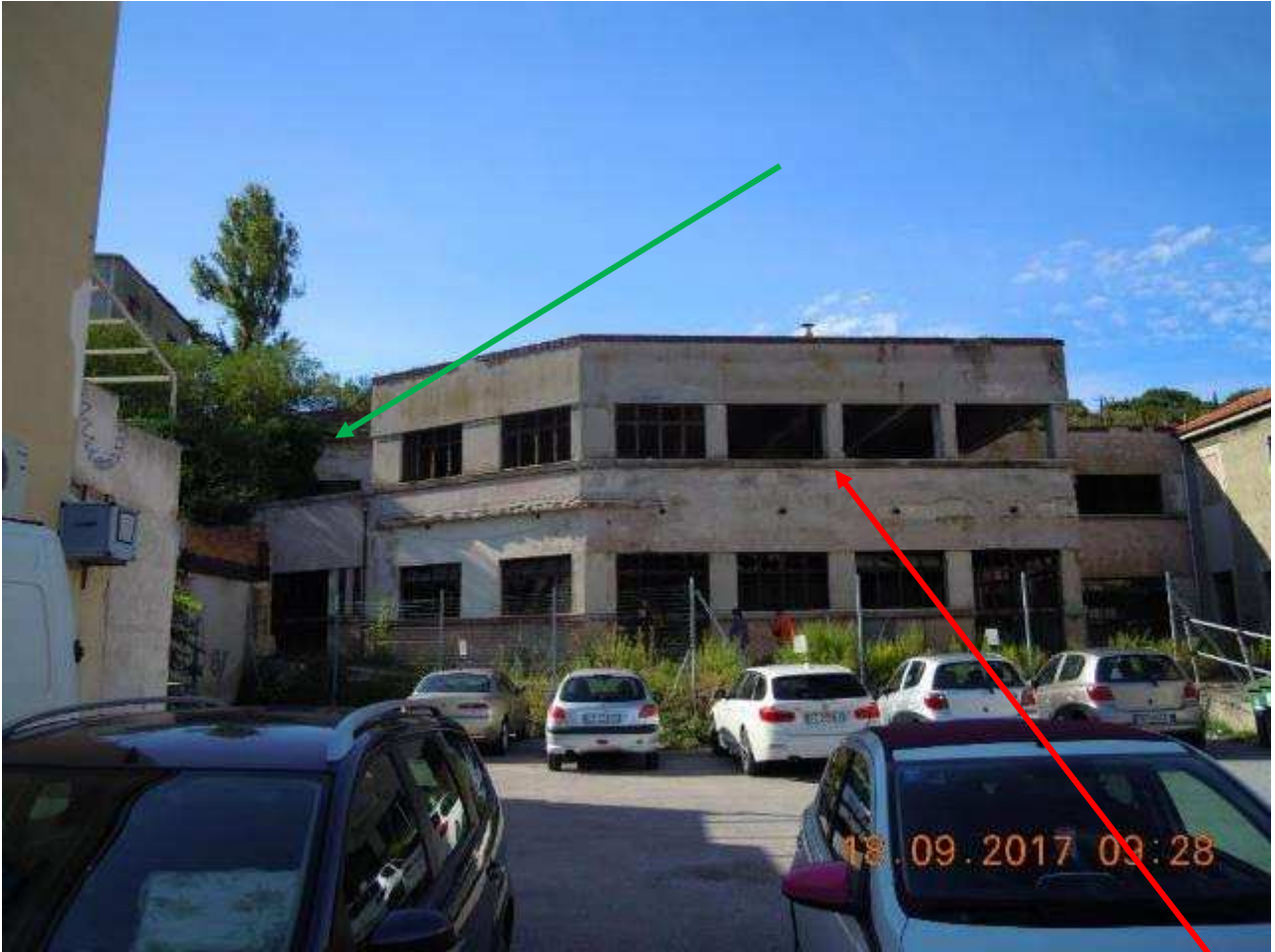
Foto n. 1: vista del complesso edilizio. Edificio E1 (rosso) ed E3 (verde su piazzale soprastante).
