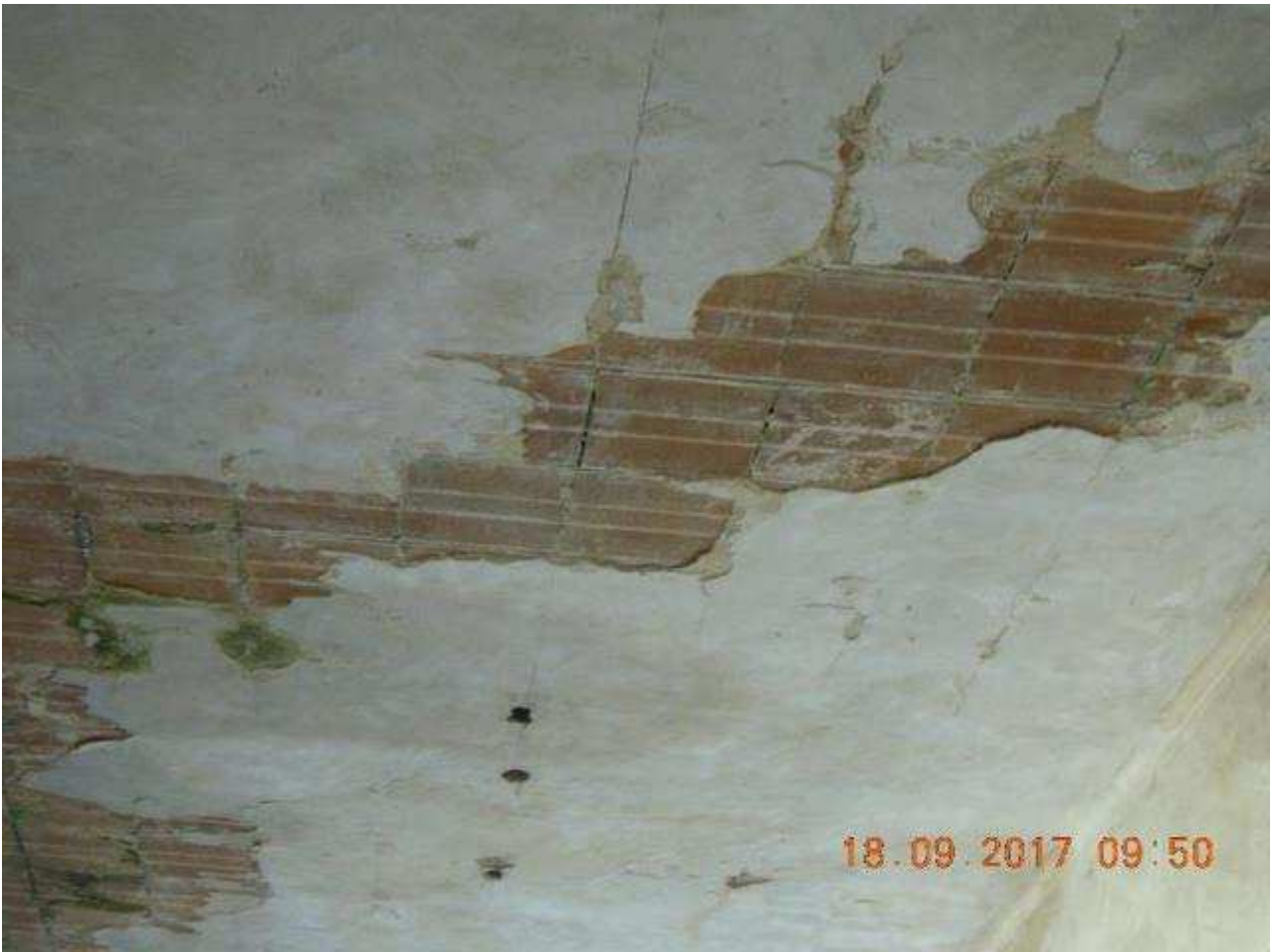
Foto n. 10: dettaglio strutture solai in latero cemento dell' edificio E1
