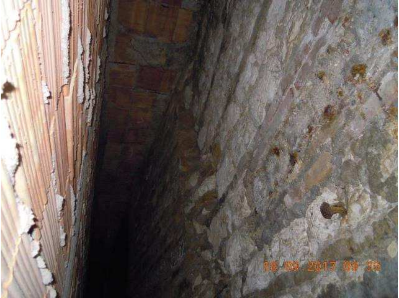
Foto n.20: muro controterra in pietra (piano terra) e vista di dettaglio del solaio di piano.
