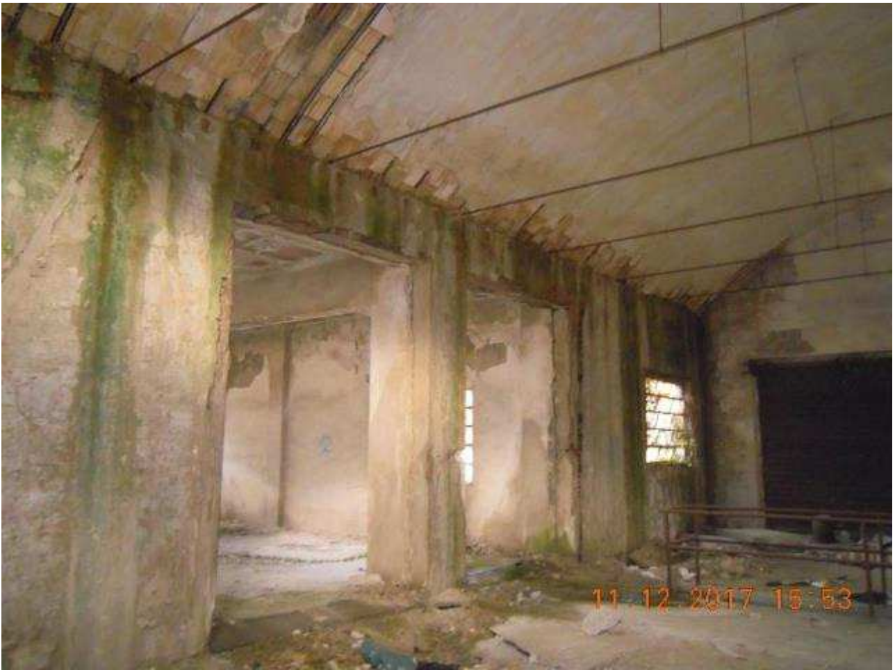
Foto n. 13: interno edificio E2
