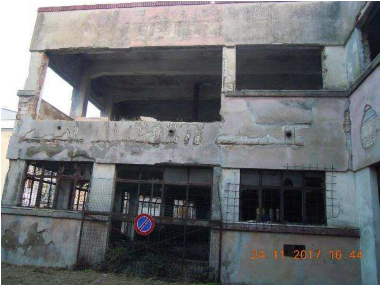
Foto n. 4: dettaglio stato di conservazione del fabbricato E1.
