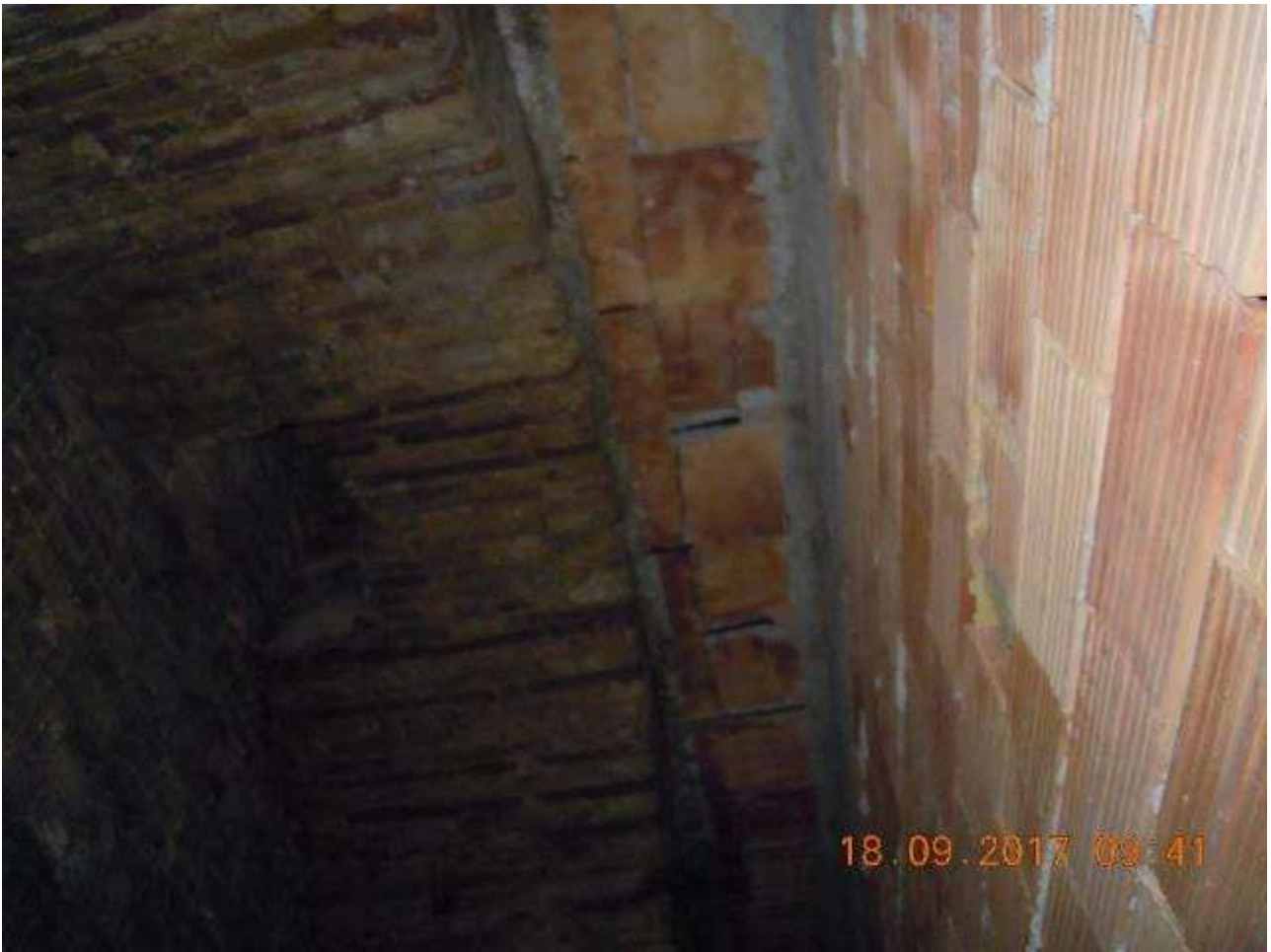
Foto n.19: interno intercapedine muro divisorio – muro controterra in pietra (piano terra). Vista di un contrafforte voltato.
