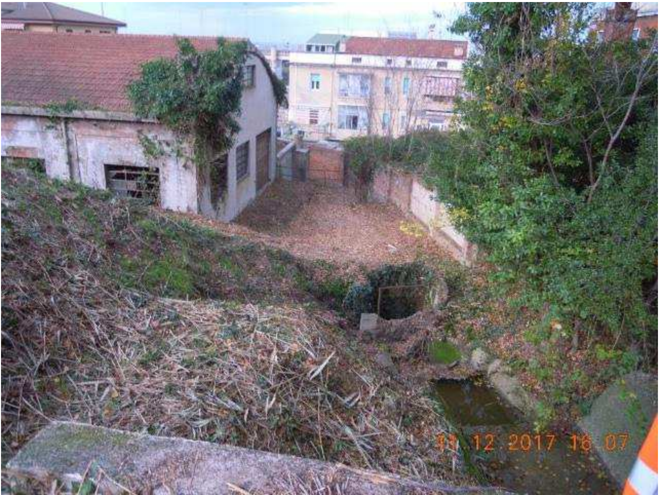
Foto n. 15: esterno edificio E2 e vista manufatti di regimazione acque confinanti
