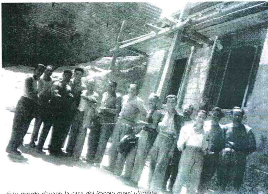
Foto ricordo davanti la casa del Popolo quasi ultimata
