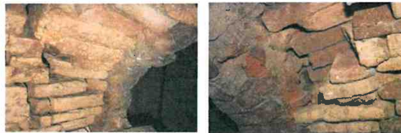
Particolare della muratura antica presente all'interno della casa risalente ad un periodo compreso tra il 1813 e il 1860.
