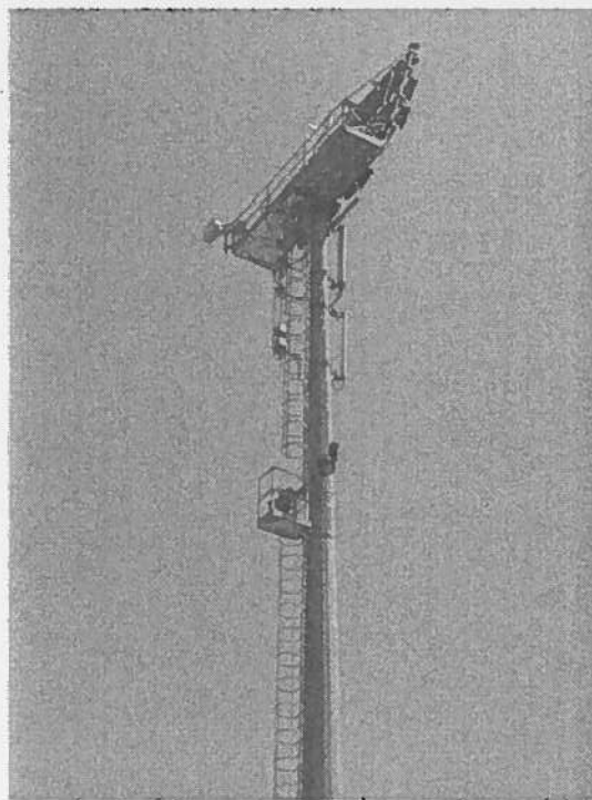
FOTO 2 – Vista della struttura porta antenne e parabole
