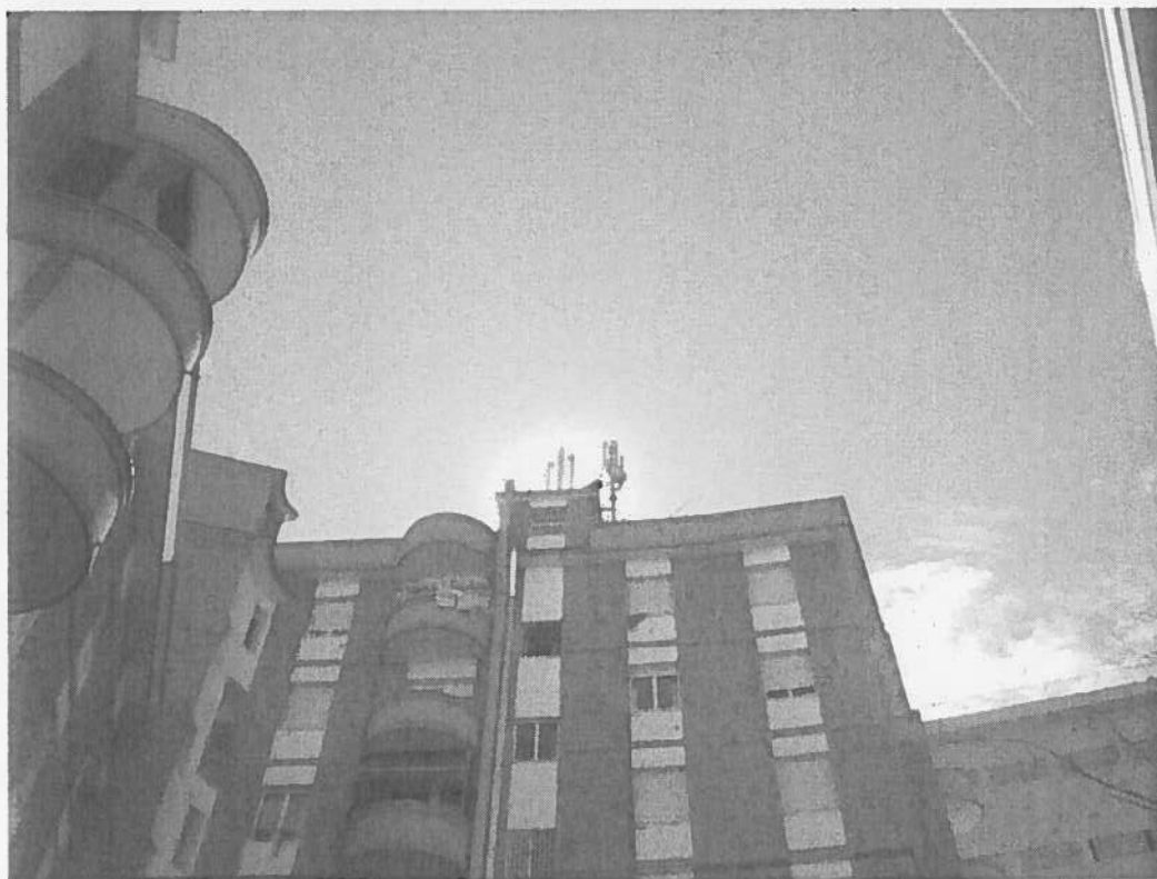
FOTO 2 – Vista d'insieme della stazione radio base
