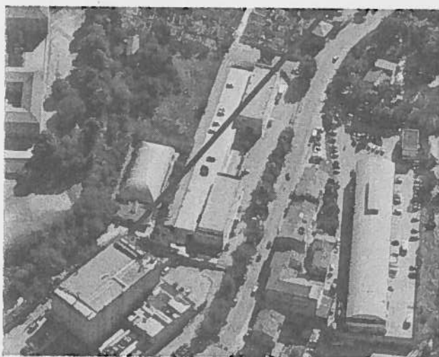
VISTA DIREZIONE SETTORE 1 VODAFONE – 120°NORD
