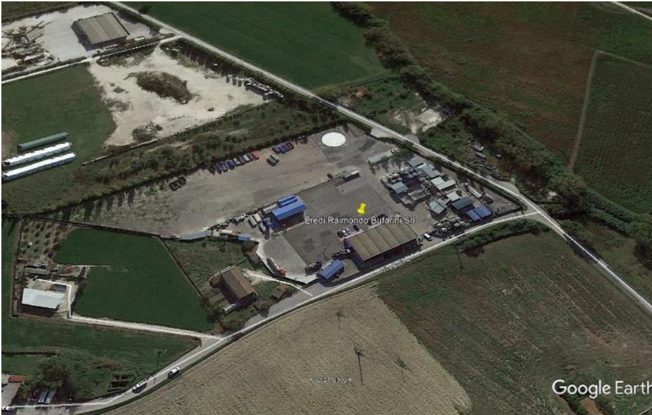
Figura 4 - Foto Panoramica dello stabilimento vista da sud
